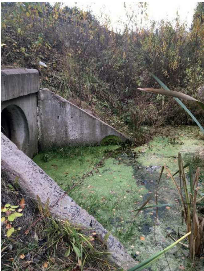
Рис.7. Водопропускная труба под автомобильной дорогой Восточный обход
