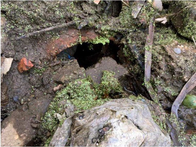
Рис.6. Вид на пруд на р.Амбарке (слева – частично забитая мусором водопропускная труба)
