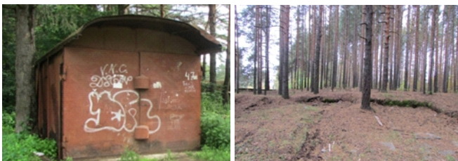
Демонтаж самовольно установленных на территории лесов объектов
