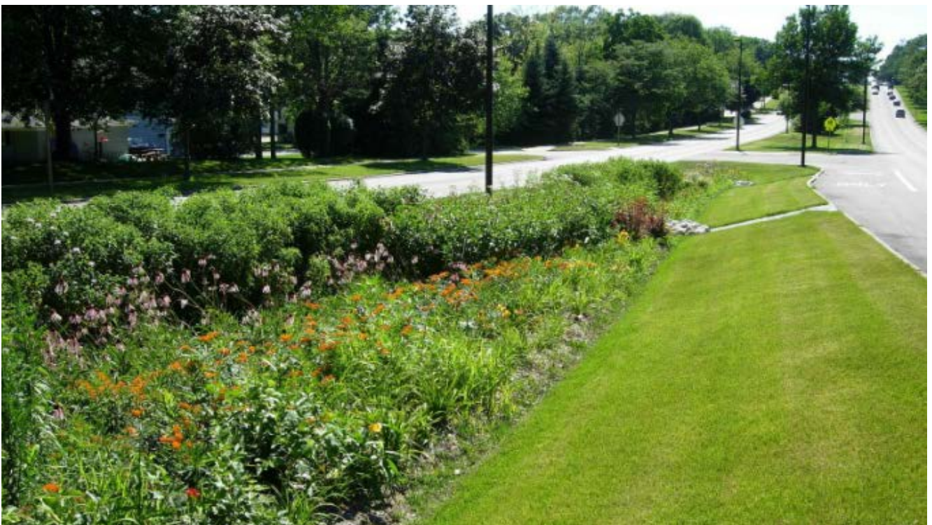
Фото 1. Фитофильтр для очистки ливневых стоков
