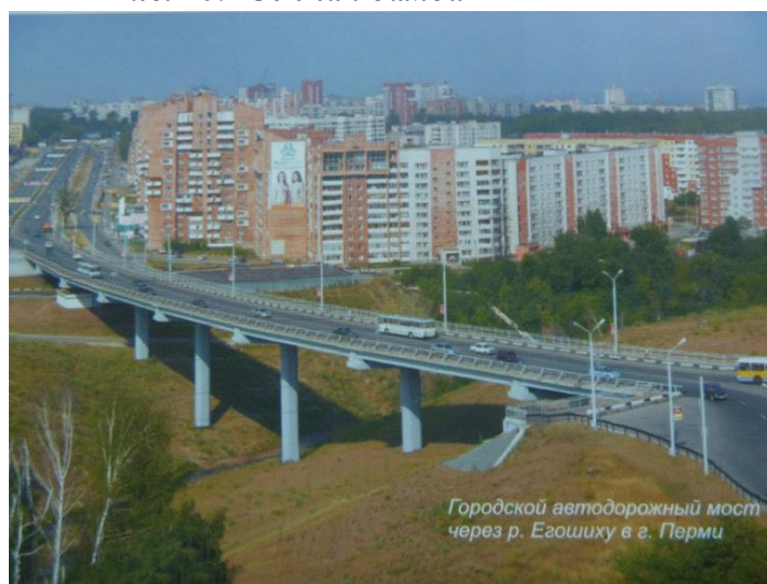
Рис. 11. Мост через Егошиху
