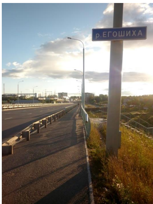
Рис.12. Мост через р.Егошиха
